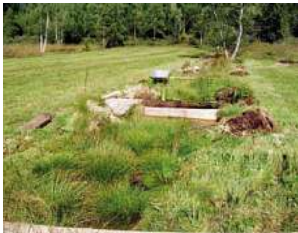
Abb. 13.5: Ein Graben wird mit Brettern eingestaut.
